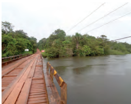
Figura 7: Ponte sobre o Rio Pantanari
