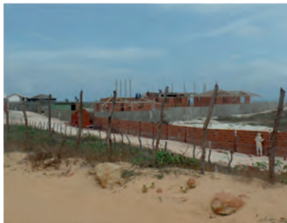
Figura 2: Construções em área de dunas
