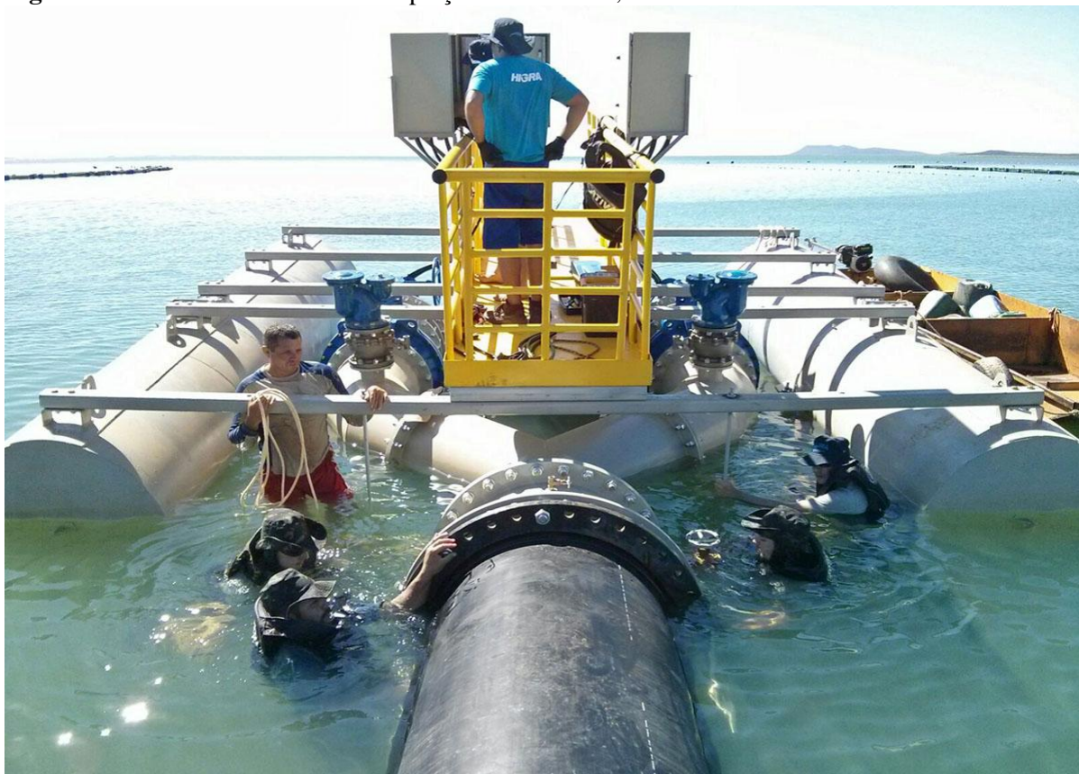
Figura 105 - Estrutura flutuante de captação Nilo Coelho, Petrolina - PE. Casa Nova - BA.
