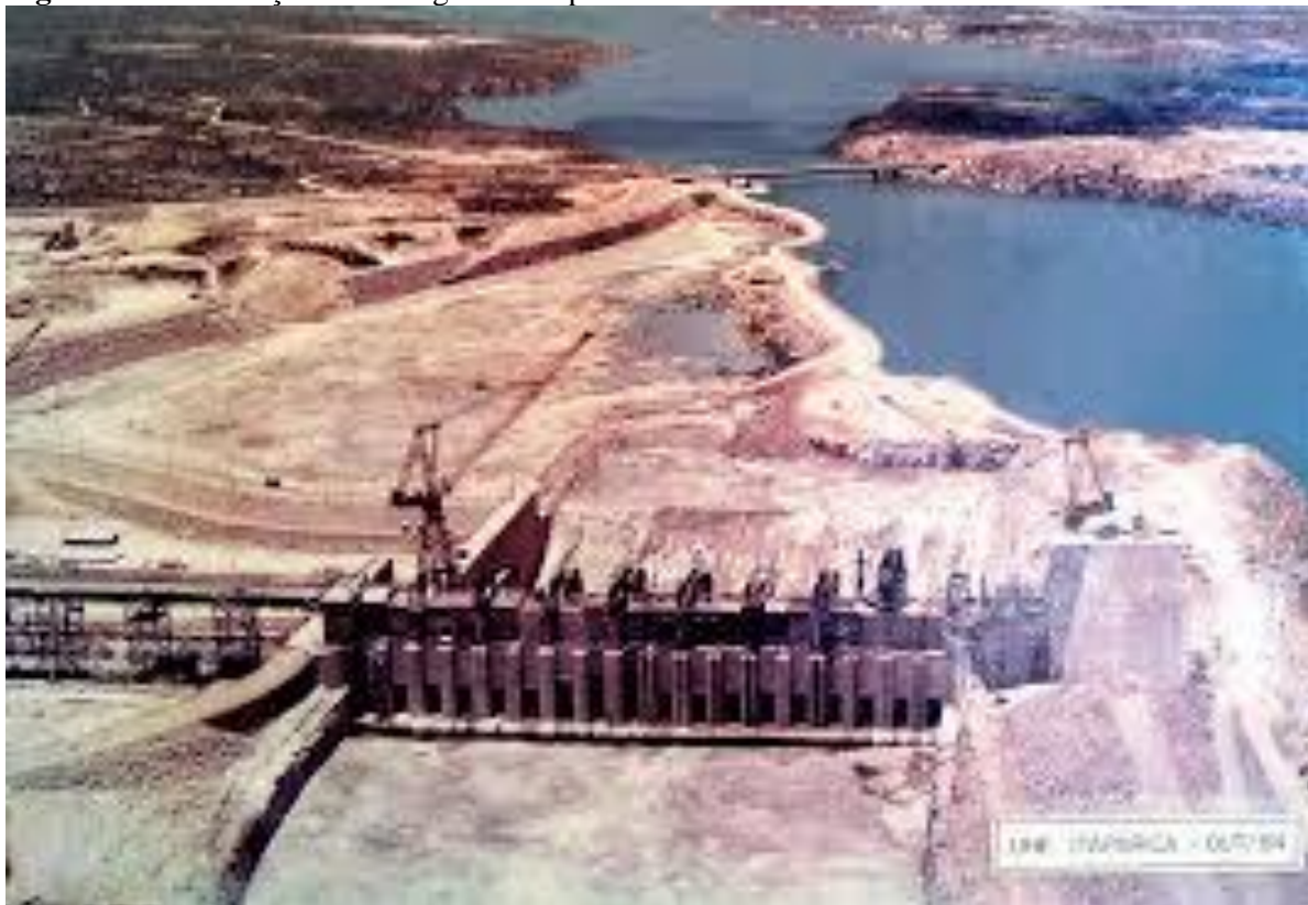
Figura 76 - Construção da Barragem de Itaparica década de 1980 - Petrolândia - PE.
