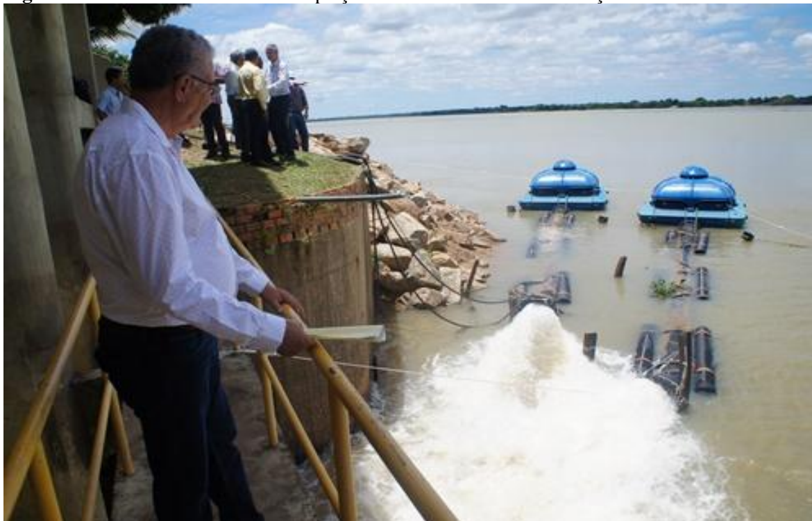
Figura 112 - Estrutura flutuante de captação - CODEVASF - Polo Maniçoba. Juazeiro - BA.
