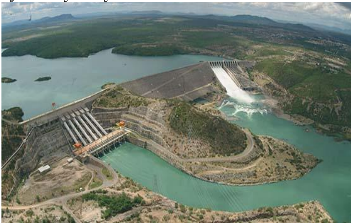
Figura 80 - Barragem de Xingó - Piranhas - AL.
