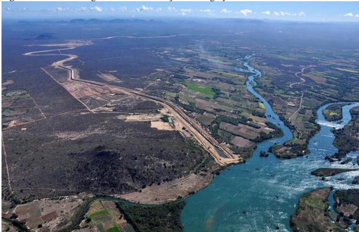
Figura 153 - Tomada d'água - Eixo Norte - Projeto de Integração do São Francisco. Cabrobró- PE.
