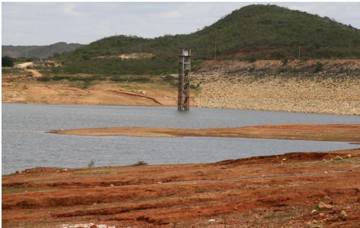
Figura 92 – Açude e estrutura de captação - Polo Brumado. Livramento de Nossa Senhora - BA - DNOCS.
