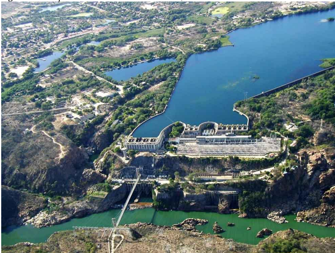
Figura 57. Complexo de Usinas de Paulo Afonso I, II e III. Paulo Afonso - BA.
