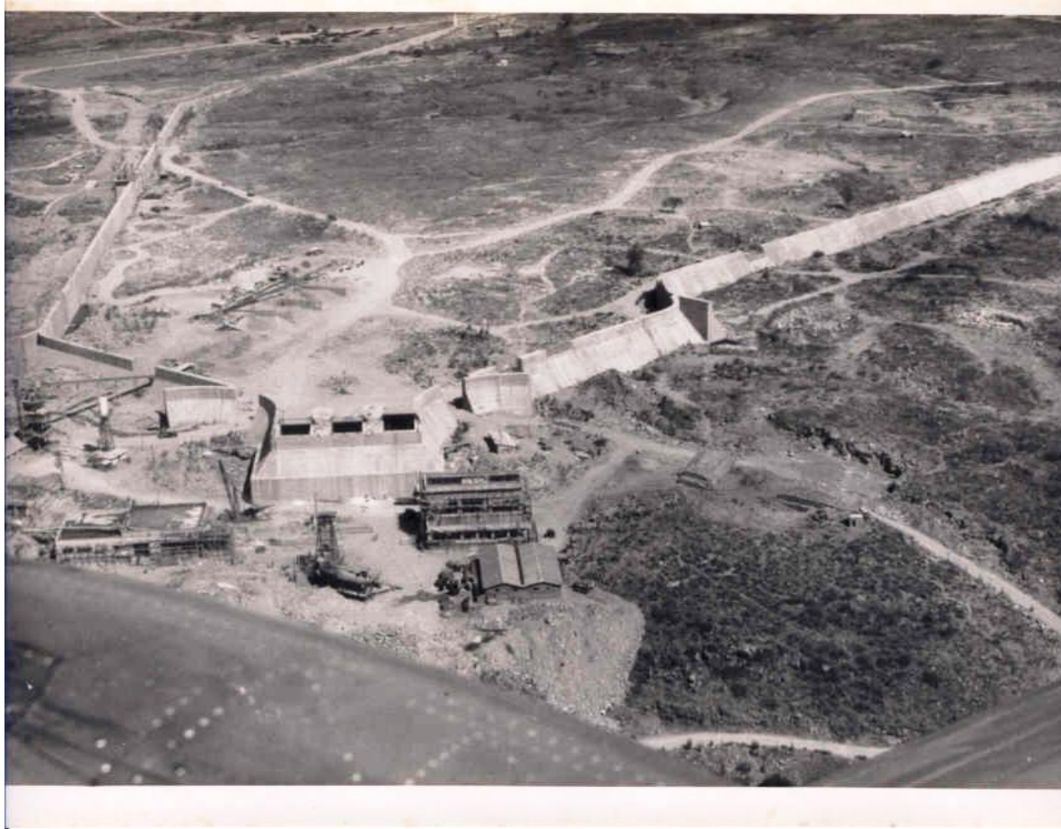
Figura 52 - Construção do dique e usina Paulo Afonso I - rio São Francisco. P. Afonso - BA.
