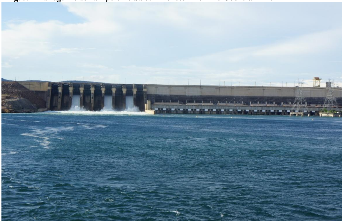
Fig. 59 - Barragem e usina Apolônio Sales - Moxotó - Delmiro Gouveia - AL.
