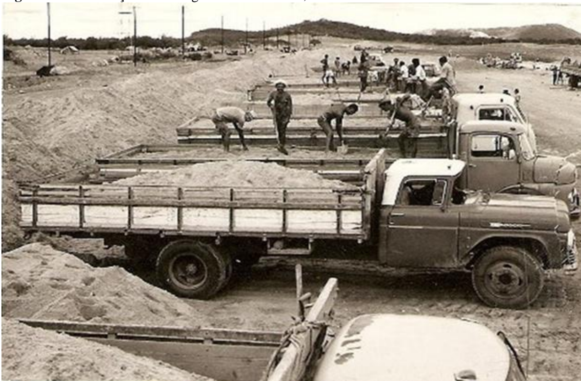
Figura 69 - Construção da Barragem de Sobradinho, Década de 1970 - Sobradinho - BA.
