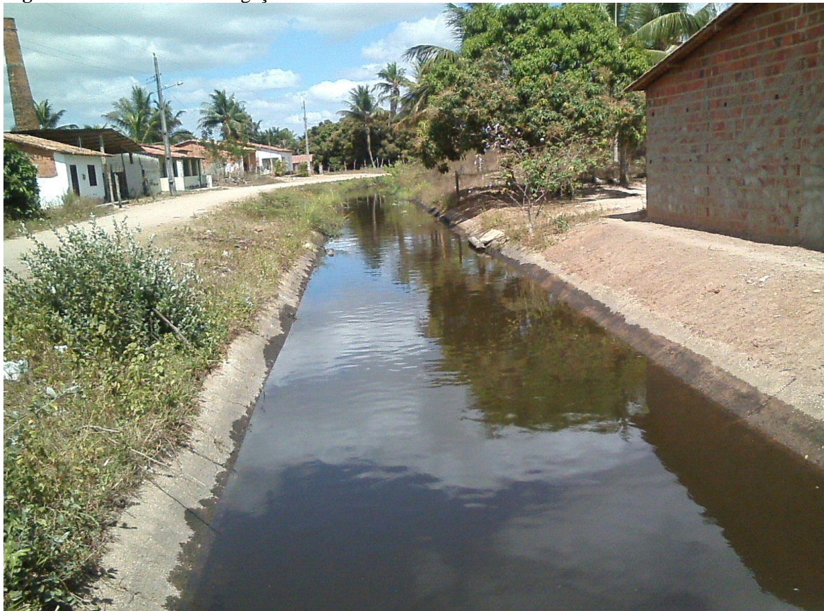
Figura 97 - Perímetro de Irrigação CODEVASF - Ilha das Flores - SE .
