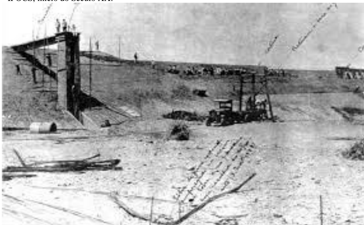
Figura 90 - Construção do açude público de Cruzeta - RN - Inspeção Federal de Obras Contra a Seca – IFOCS, início do Século XX.
