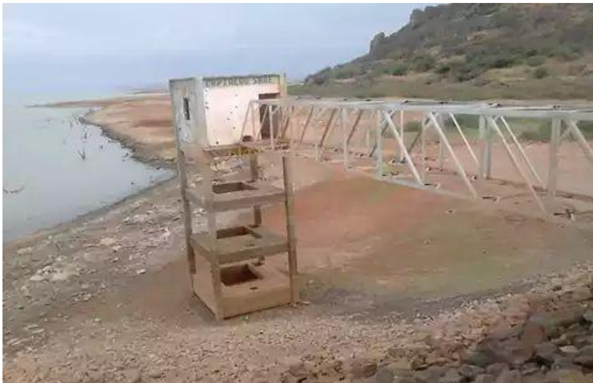
Figura 115 - Estrutura de Captação de água da CODEVASF. Seca 2014. Município de Sento Sé - BA.
