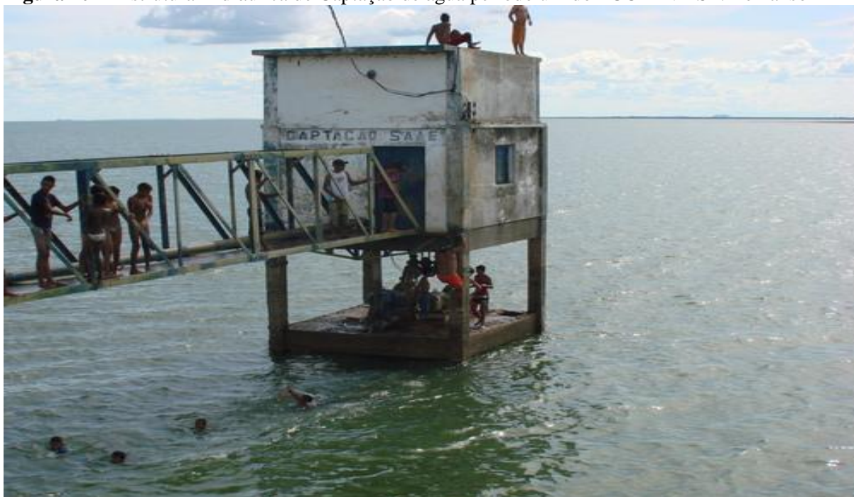
Figura 101 - Estrutura Hidráulica de Captação de água período úmido - CODEVASF. Remanso - BA.
