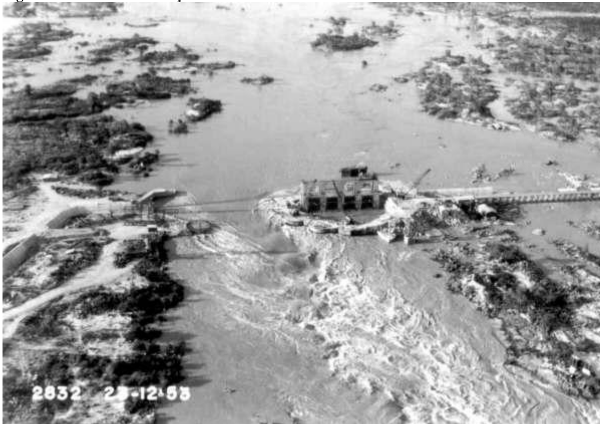
Figura 48 - Início da construção de enseadeiras sobre o rio São Francisco. Paulo Afonso - BA.
