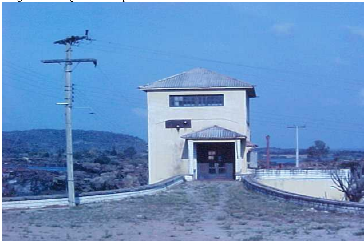
Figura 45 - Antiga usina de Itaparica - cidade de Petrolândia - PE.
