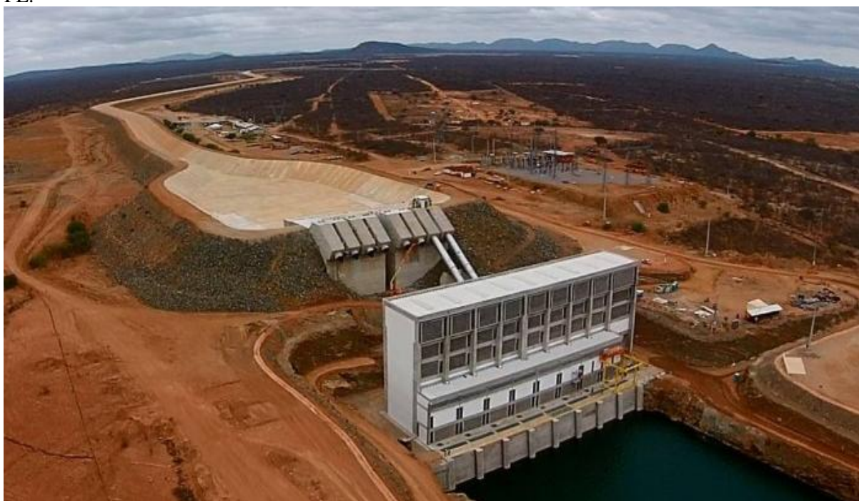
Figura 154 - Estação de bombeamento - Eixo Norte - Projeto de Integração do São Francisco. Cabrobró-PE.
