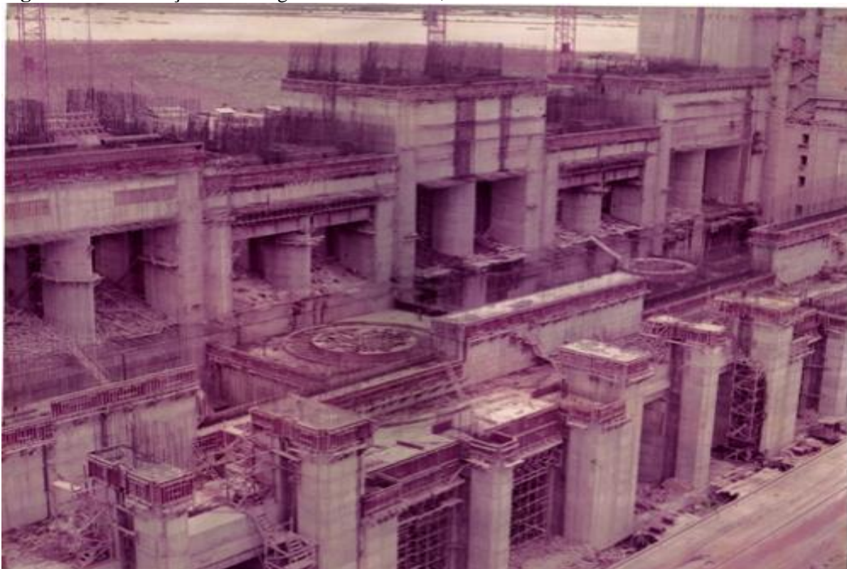
Figura 70 - Construção da Barragem de Sobradinho, Década de 1970 - Sobradinho - BA.
