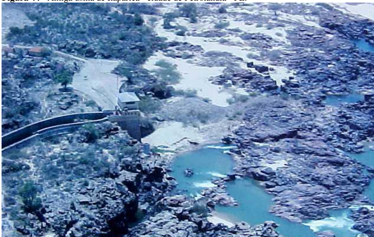
Figura 44 - Antiga usina de Itaparica - cidade de Petrolândia - PE.
