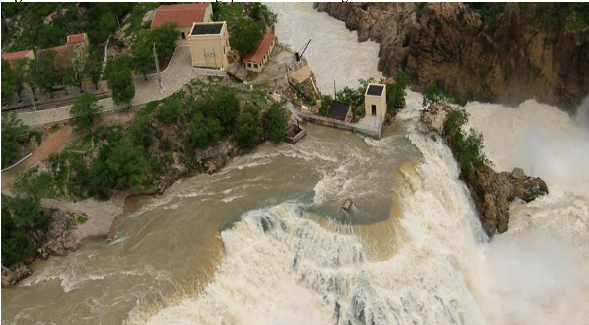
Figura 41 - Usina hidrelétrica de Angiquinho - tomada d'água - Delmiro Gouveia - AL.
