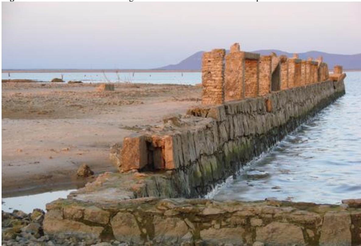
Figura 122 - Ruínas do cais da antiga Remanso. Seca de2014 - Município de Remanso - BA.
