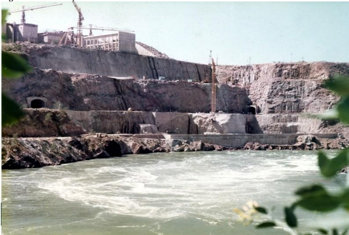
Figura 61 - Construção da Usina de Paulo Afonso IV - Paulo Afonso - BA.
