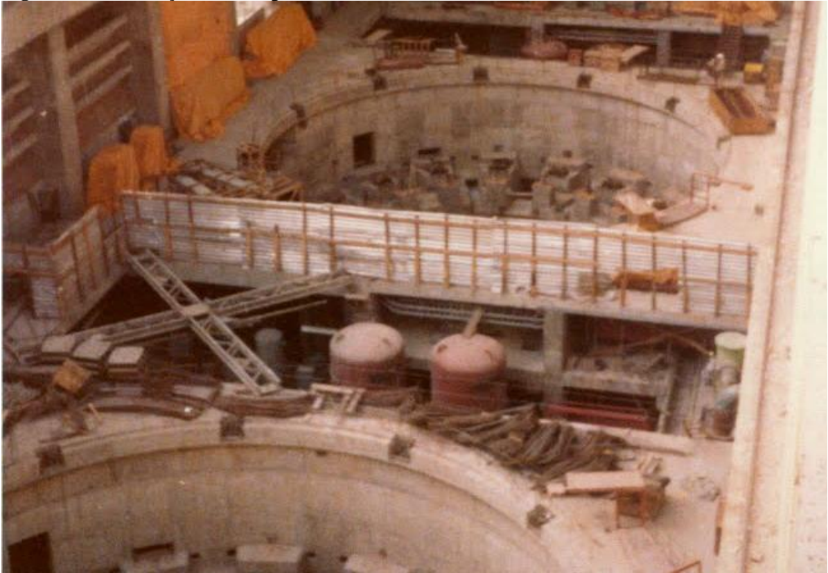
Figura 71 - Construção da Barragem de Sobradinho, Década de 1970 - Sobradinho - BA.
