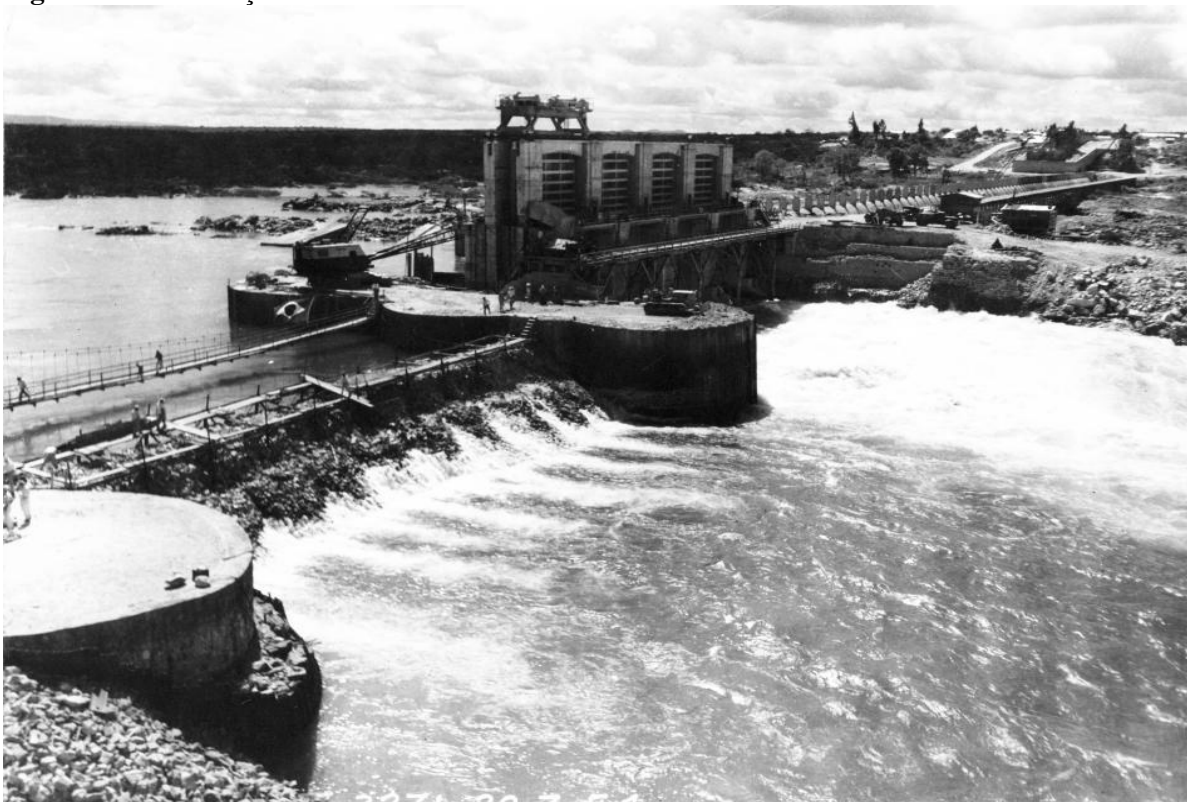
Figura 50 - Construção de ensecadeiras sobre o rio São Francisco. Paulo Afonso - BA.
